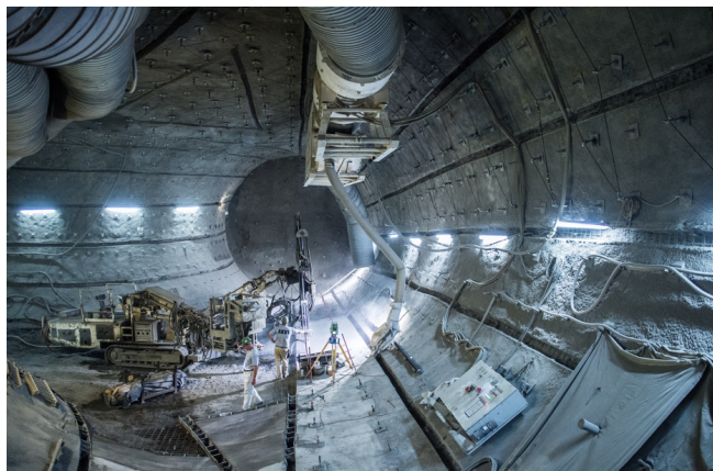
Technici bereiden de opslag voor van radioactief afval in een voormalige ijzermijn in het Duitse Salzgitter. © dig
